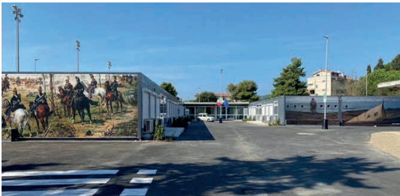
Figura 5 – Scuola modulare prefabbricata temporanea, Comune di Rosignano Marittimo, 2021
