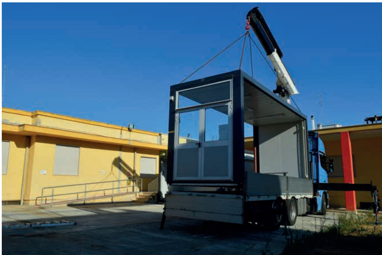
Figura 1 – Modulo prefabbricato, modalità di trasporto attraverso camion con gru
