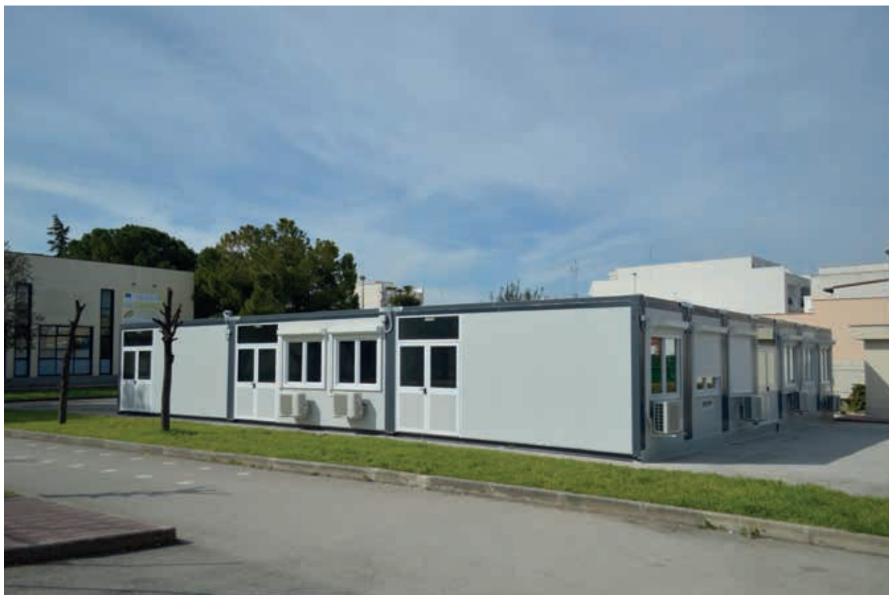
Figura 4 – Scuola modulare prefabbricata temporanea, Comune di Andria, 2022
